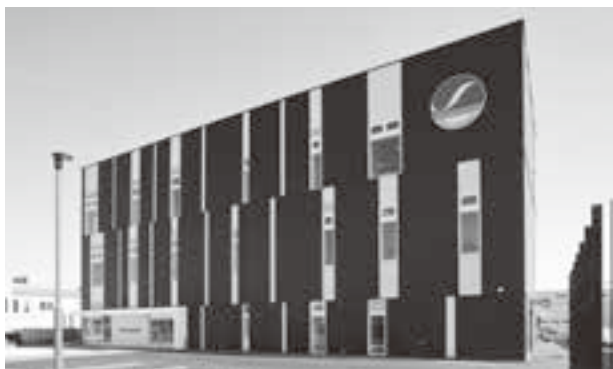
仙台支店新社屋「シティフォレスト宮城野ビル」
