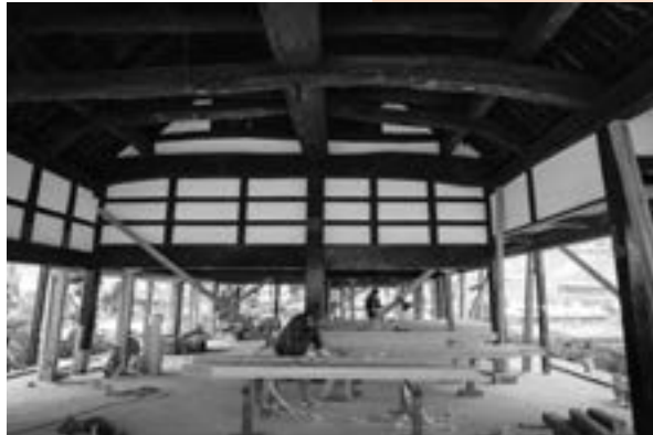
「アキウ舎」再生時の様子
