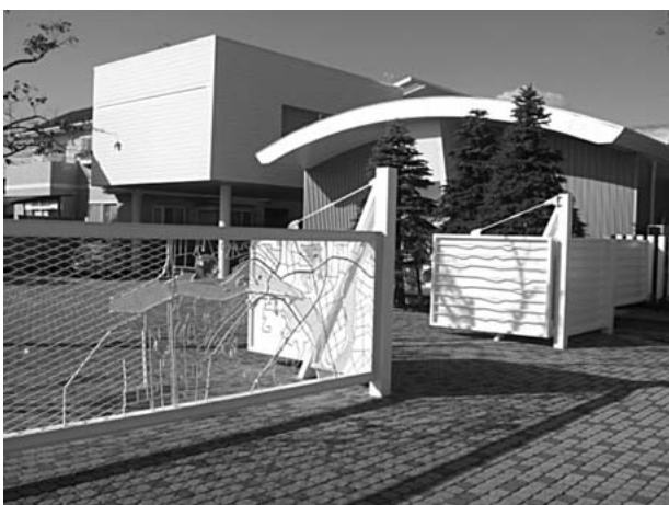
多目的施設木の屋KANKANホール
