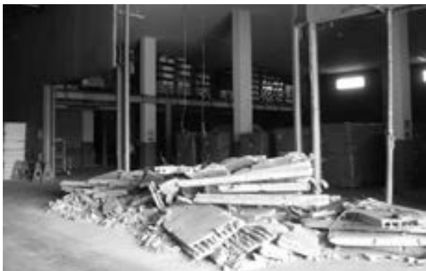
震災時の倉庫の様子
