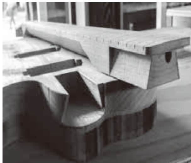
気仙大工の技術による結合部分の細工
