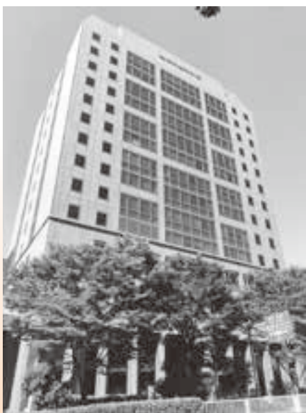
本社 (TDCビル)
