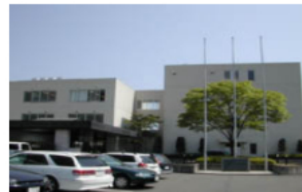
本社・フッ化カルシウム結晶製作研究棟(ICRビル)
