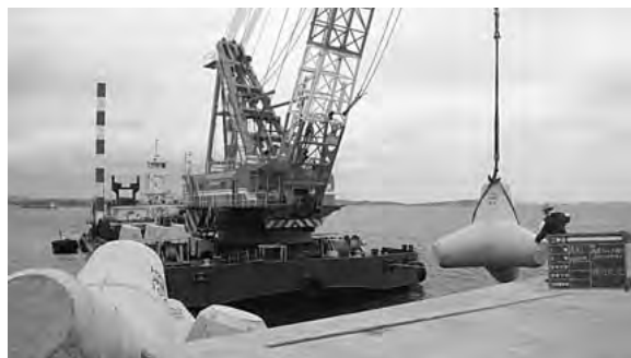
仙台港沖防波堤工事
