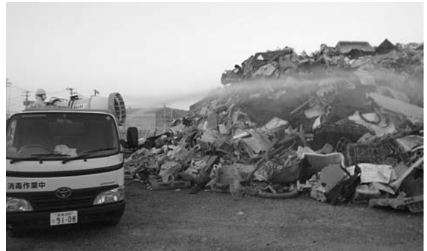
「スパウダー」を利用した瓦礫への消毒作業
