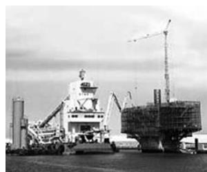
「コンクリートプラント船」
