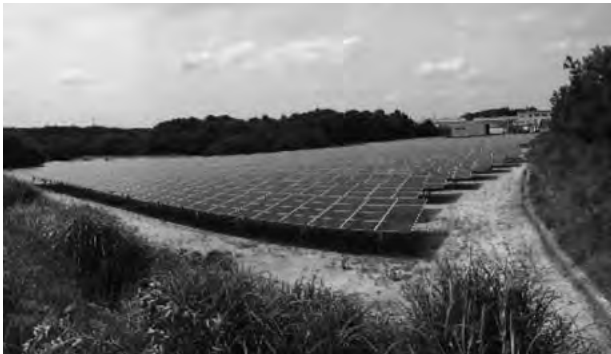
加美町にある孫沢発電所
