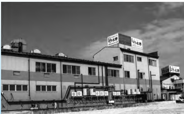
本社社屋・工場
