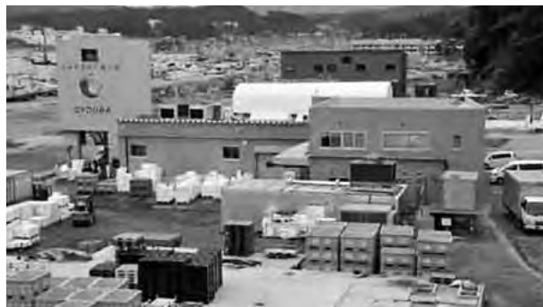
震災の5ヵ月後の復旧した本社全景
